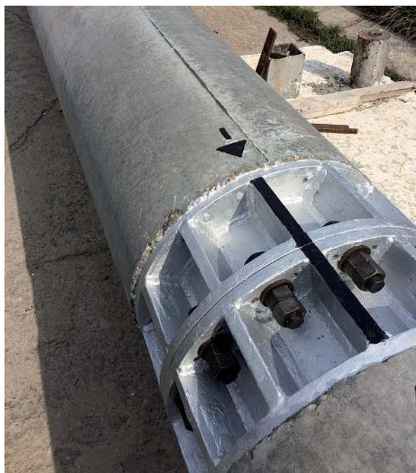
Рис. 1. Фланцевое соединение секций
