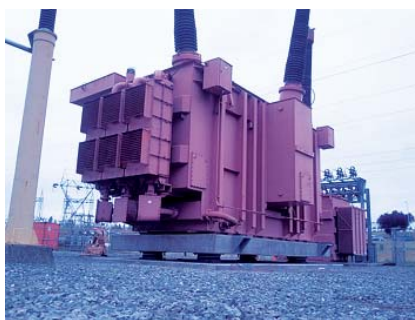
Рис. 5. Сейсмоизоляция трансформатора 460 кВ (установка на демпферы)
