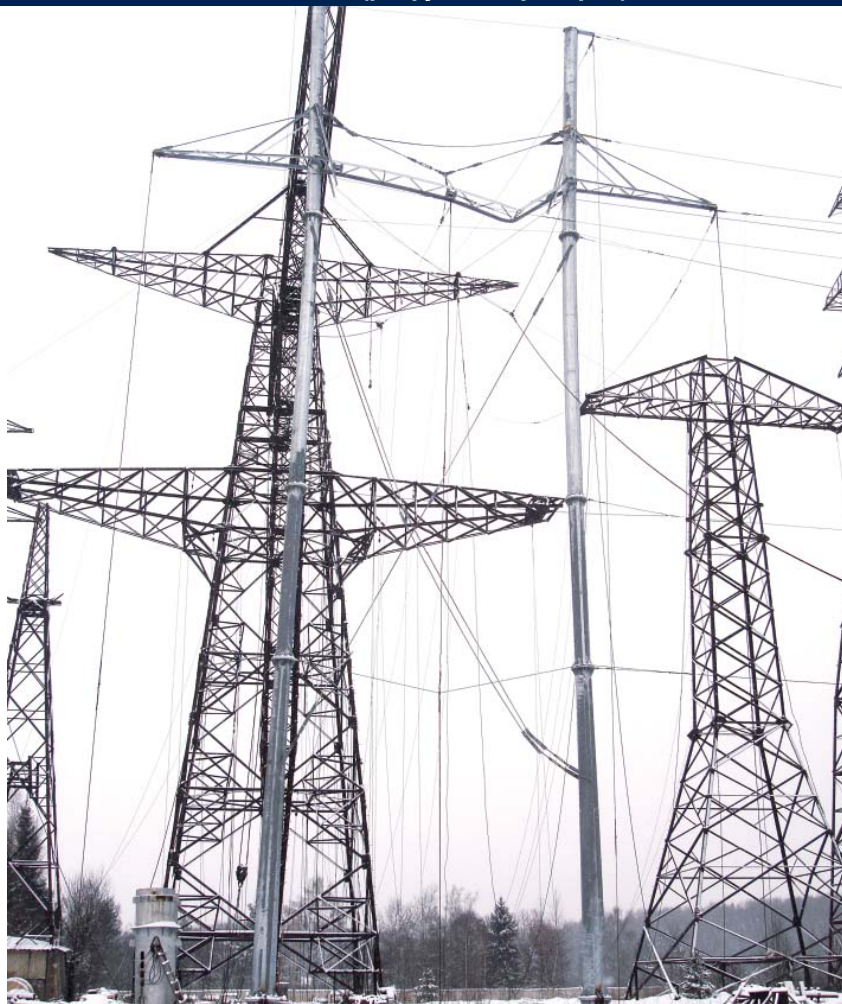
Рис. 4. Неуспешные испытания опоры типа ПМГ для ВЛ 500 кВ (разрушена траверса)
