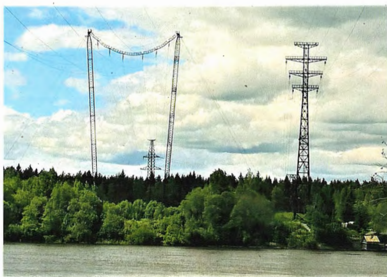
Рис. 3. Специальный двухцепный переход ВЛ 110 кВ Л1–Л2 ПАО «Ленэнерго» у г. Кировск (Ленинградская область) на промежуточных опорах ПГТ110-2/70 с гибкой вантовой или тросовой траверсой и А-образными оттяжками. Это один из первых переходов через Неву, разрушенный во время Великой Отечественной войны и затем восстановленный [3] (фото автора, июль 2017)
