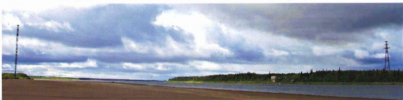
Рис. 7. Действующий переход через р. Уса, основной пролет 1550 м (фото автора, июль 2007)
