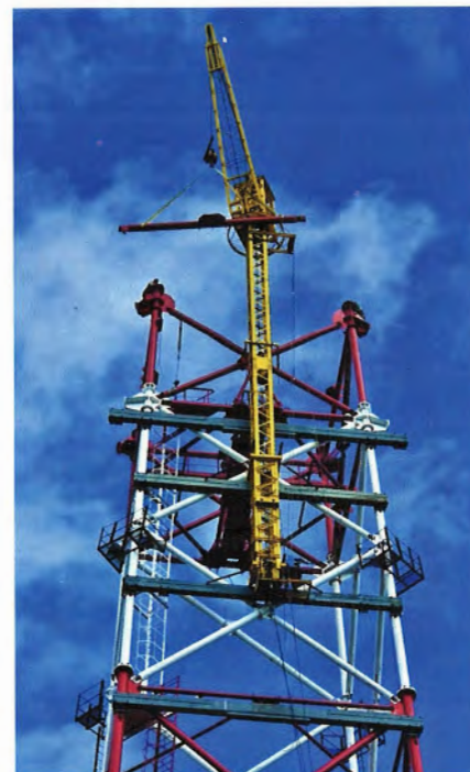
Рис. 11. Левобережная анкерная опора АТ-73М на затопляемом половодьем берегу, установленная на четыре стойки монолитных железобетонных ростверков, и ледозащита из 25-ти надобл, объединенных распорками. Позлементный монтаж способом наращивания при помощи «ползучего» крана (фото автора, август 2021 года)
