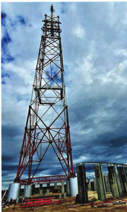
Рис. 11. Левобережная анкерная опора АТ-73М на затопляемом половодьем берегу, установленная на четыре стойки монолитных железобетонных ростверков, и ледозащита из 25-ти надобл, объединенных распорками. Позлементный монтаж способом наращивания при помощи «ползучего» крана (фото автора, август 2021 года)
