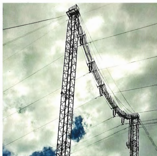
Рис. 3. Специальный двухцепный переход ВЛ 110 кВ Л1–Л2 ПАО «Ленэнерго» у г. Кировск (Ленинградская область) на промежуточных опорах ПГТ110-2/70 с гибкой вантовой или тросовой траверсой и А-образными оттяжками. Это один из первых переходов через Неву, разрушенный во время Великой Отечественной войны и затем восстановленный [3] (фото автора, июль 2017)
