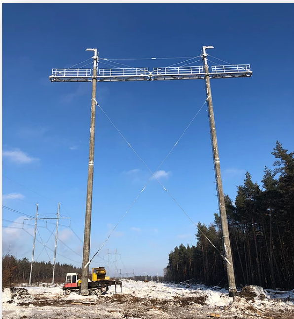
Рис. 2 Опора 2СПБ500-3В на ВЛ500 кВ «Донская АЭС - Старый Оскол 2»
