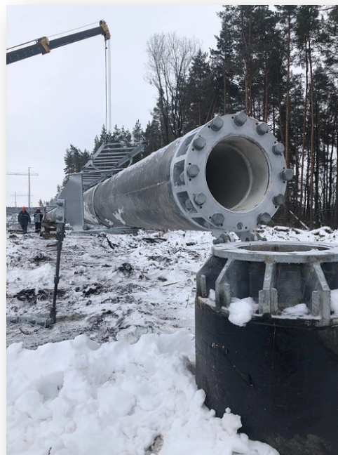
Рис. 2 Опора 2СПБ500-3В на ВЛ500 кВ «Донская АЭС - Старый Оскол 2»
