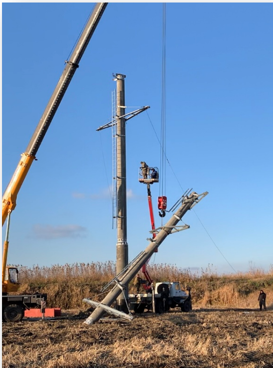
Рис. 7. Монтаж средней секции
