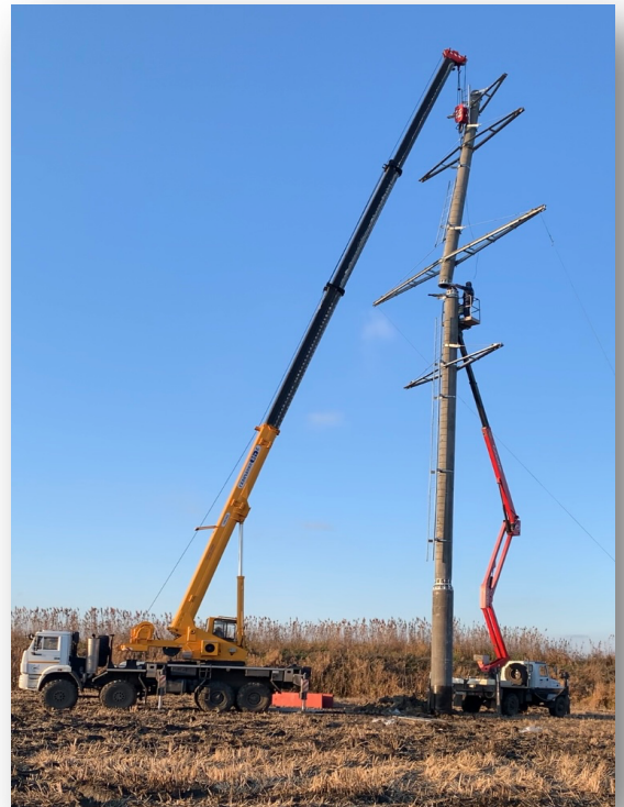
Рис. 8. Монтаж верхней секции
