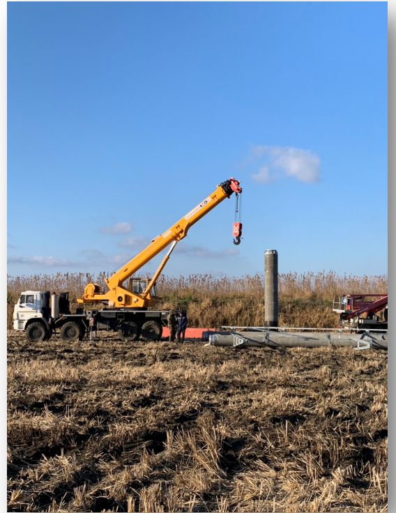
Рис. 6. Монтаж нижней (фундаментной) секции
